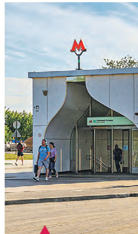
Группа компаний «Мосинжпроект» является генеральным подрядчиком и генпроектировщиком новых станций Московского метрополитена. Их строительство идет в разных районах Москвы
