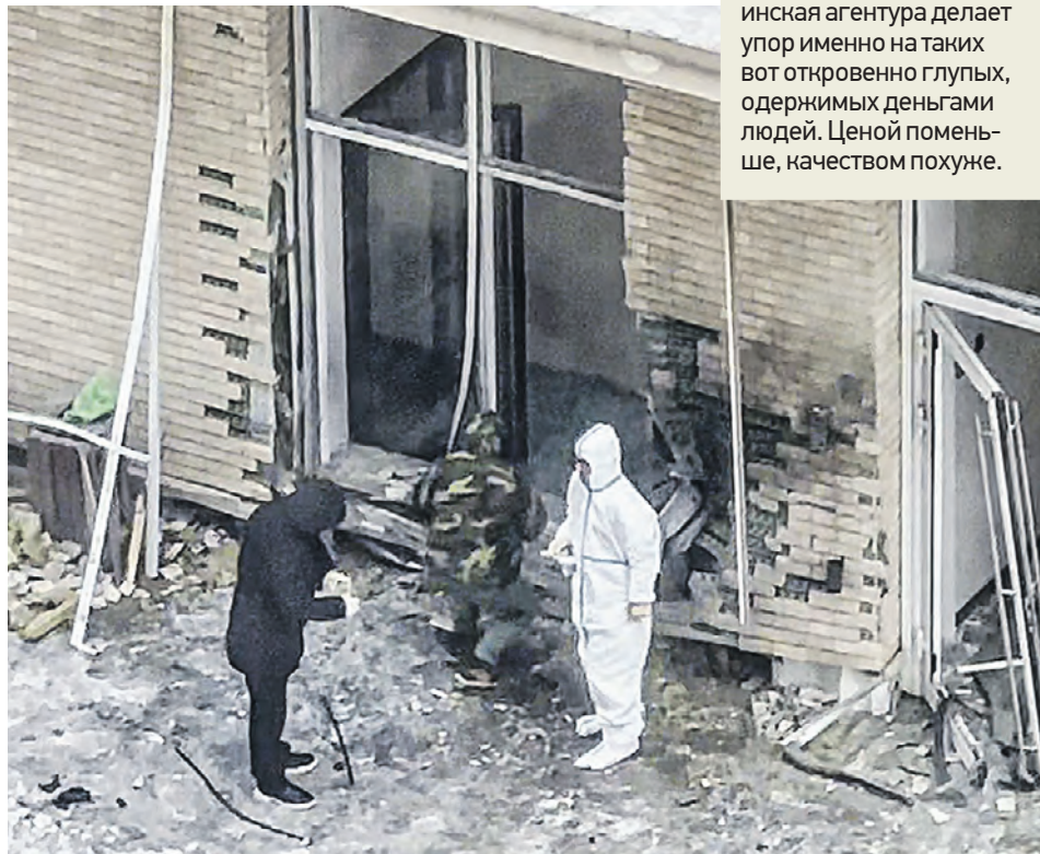
17 декабря. Последствия взрыва на первом этаже жилого дома на Рязанском проспекте
