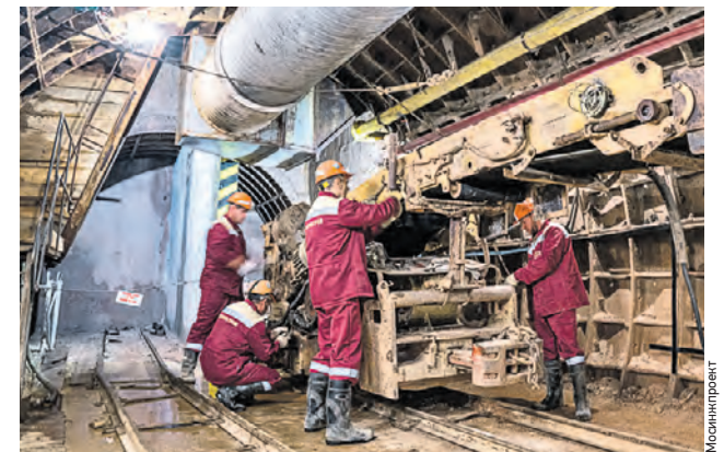
Строительство станции «Достоевская» Кольцевой линии Московского метрополитена
